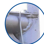
Volledig gelast frame
